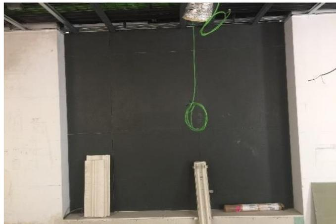
La Absorción se consigue por la vibración a flexión del panel debido a la onda incidente, siendo máxima ésta absorción para la resonancia.
